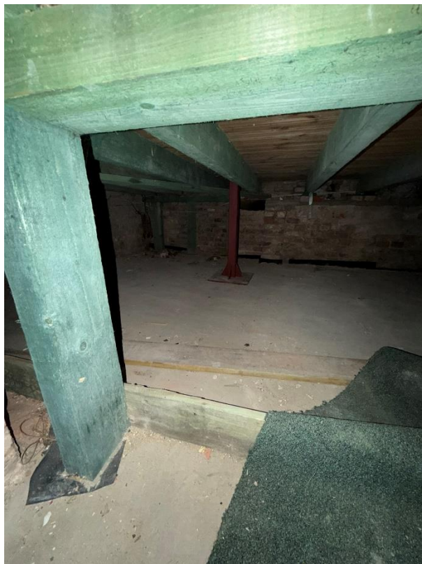
Zdj. 3 – przykład wzmocnienia pod istniejącym ekranem kinowym
