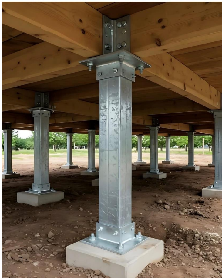
Zdj. 5 – przykład wykonania wzmocnienia w przestrzeni pod sceną
